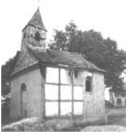
Die baufällige Kapelle am alten Standort
